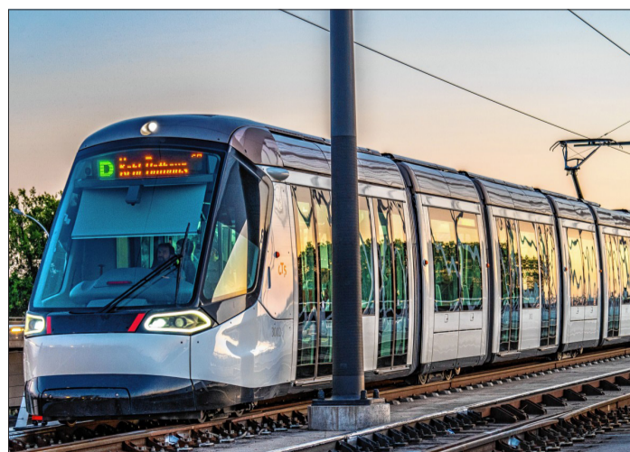
Von den umfangreichen Reparatur- und Sanierungsarbeiten des Straßburger Straßenbahnnetzes ist in großem Ausmaß auch die grenzüberschreitende Tramlinie D betroffen. Foto: Stadt Kehl
